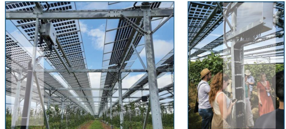
Figura 36: Ejemplos para canalizaciones en sistemas AgriPV. Fraunhofer ISE, Alemania.
