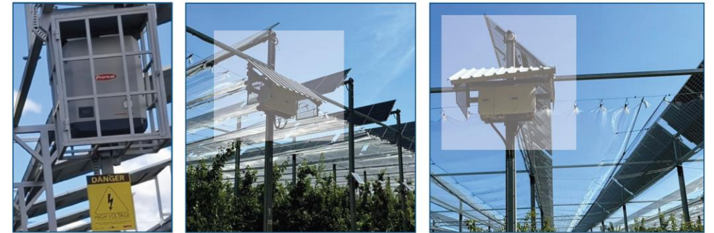
Figura 35: Inversor FV instalado en altura y protegido por una jaula metálica en un sistema AgriPV.
